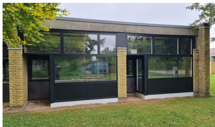
Ny facade med et ekstra lag udenpå den eksisterende facade
